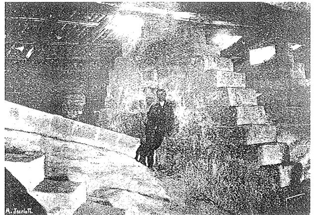
Figura 24.- Cargas sobre la clave central y los arcos transversales (Rubiò Bellver, 1912).
